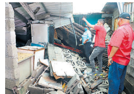
Se entregó materiales para reconstrucción.
